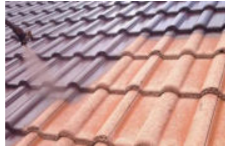
Beschichtung von Dachziegeln bei Sanierung (© KWB)
