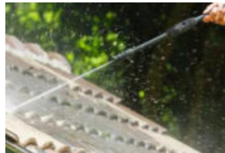
Mechanische Reinigung von Dachziegeln (© OST)
