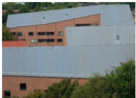
Großflächiges Metalldach aus Zinkblech (© OST)
